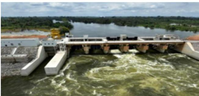
**Barrage réservoir de Lom Pangar** (capacité de retenue d'eau de 6 milliards de m<sup>3</sup>)
