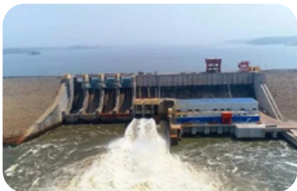
• Barrage réservoir de Lom Pangar (capacité de retenue d'eau de 6 milliards de m 3 )
