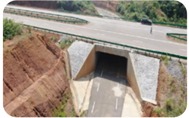
• Entrée Est de Douala-Phase 1 (route de 10 km allant du carrefour des fleurs vers le pont sur la Dibamba)
