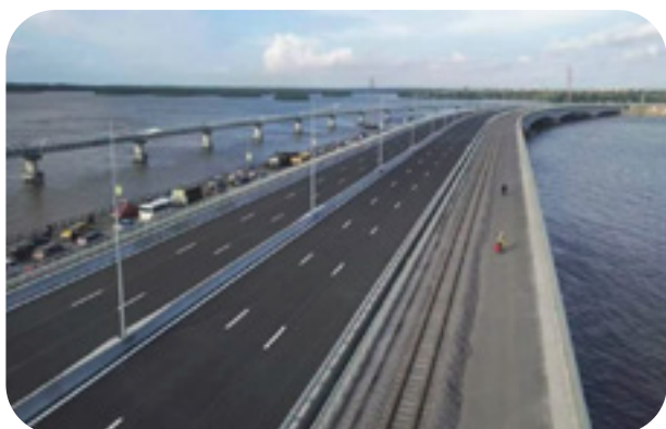
• Deuxième pont sur le Wouri (pont routier à six voies et un pont ferroviaire à deux voies)
