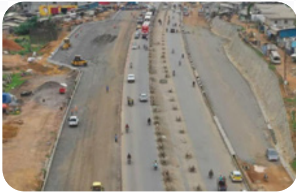
• Entrée Ouest de Douala (route 2 x 2 voies de 13 Km allant de Bonassama à Bekoko)
