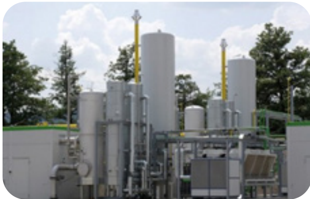
• Centrale thermique de Dibamba (capacité de production 86 Mw)
