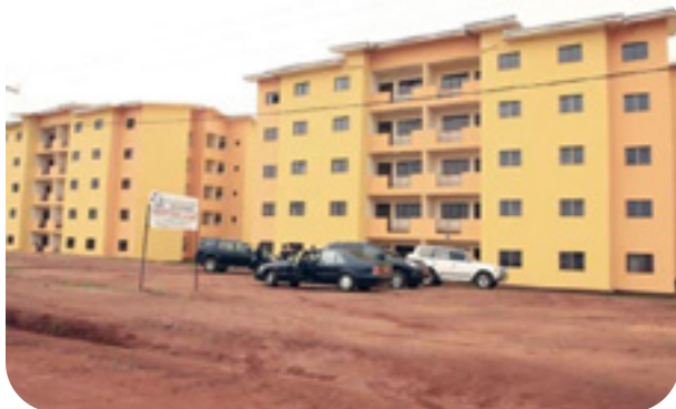
• Construction de nouveaux logements sociaux depuis 2010 (3 000)
